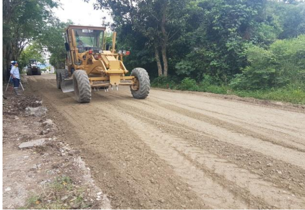
Nivelación Sub base
