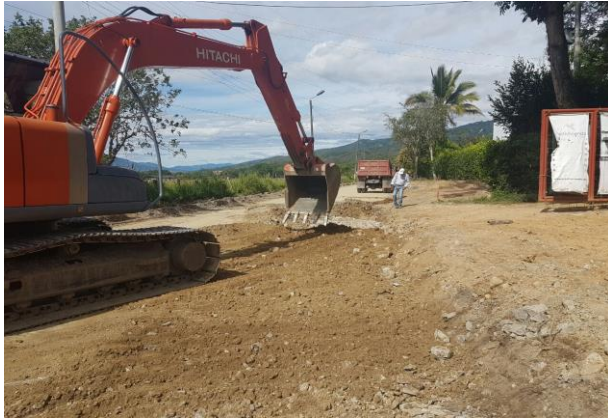
Excavación Pilotes
